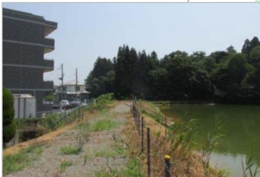
※堤体下流にマンションが隣接
